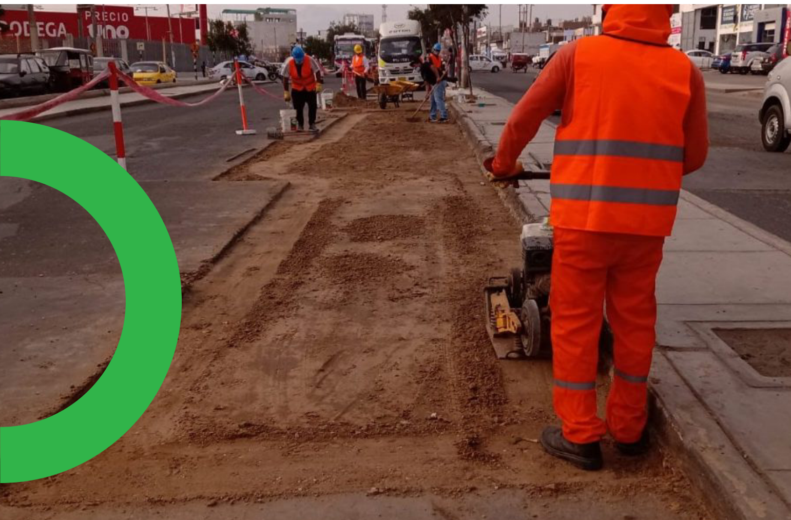
Construcción de la primera ciclovía en Trujillo. Fuente: Siente Trujillo
